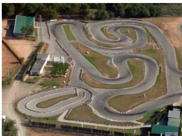
Figura 9. Vista aérea del Circuito de karting de Sallent con la sectorización por intervalos del trazado para las lecturas y registros EMGS.
