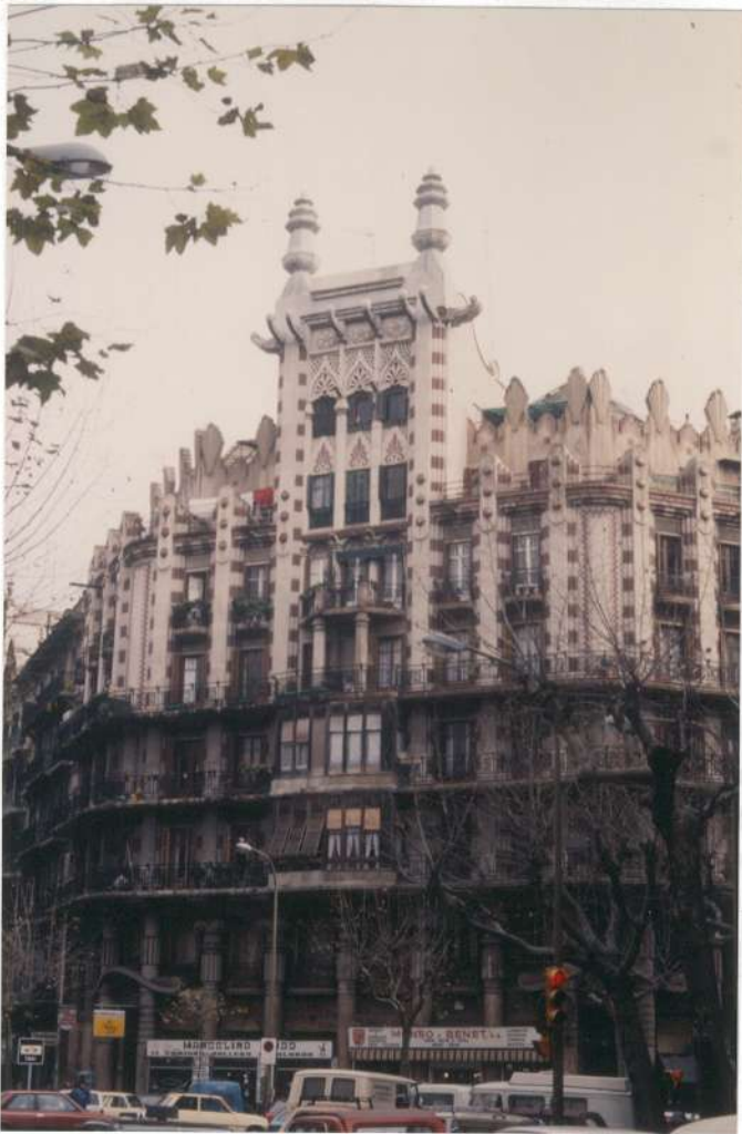
Coherente con su discurso, Domenech i Boada realiza una obra eclectica o poliestilistica en el Ensanche, donde la desorientación que atribuye a su época encuentra en este edificio su mejor y más depurado exponente.
