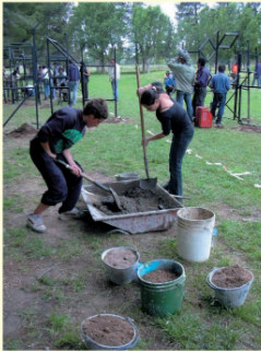
Preparación de las mezclas para las fundaciones
