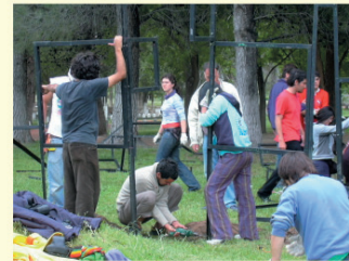
Preparación de las mezclas para las fundaciones
