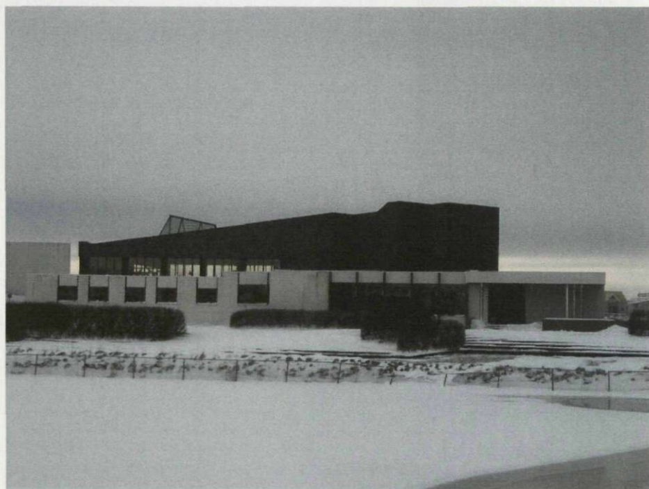
D estabilidad-horizonte, F diagonal ascendente
