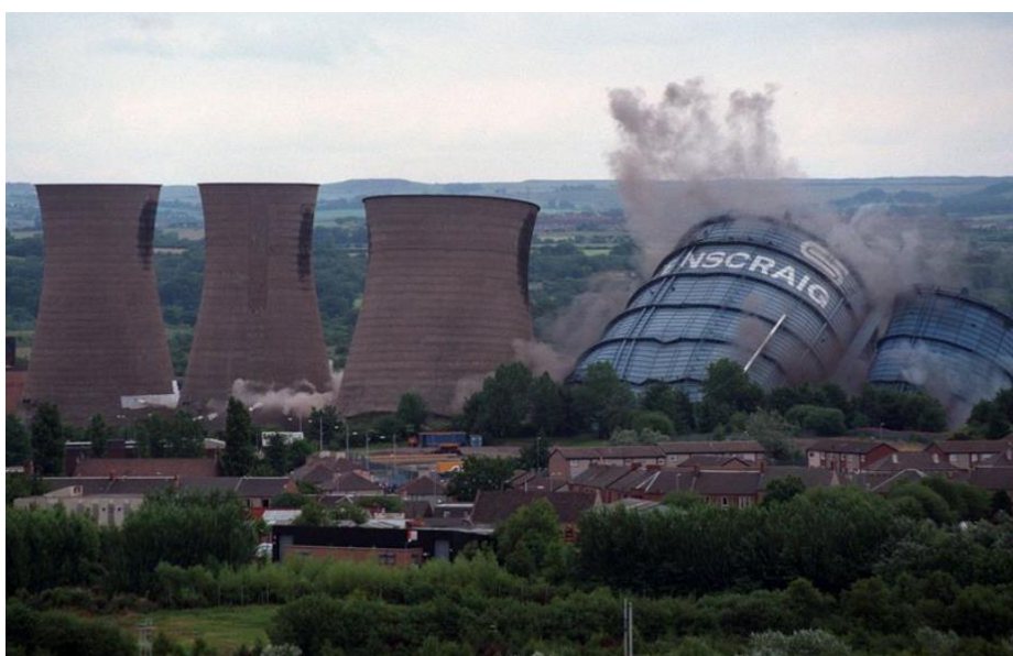
Fig. 1. Demolició de la planta Ravenscraig Steelworks, Motherwell. ©Colin Mcpherson
