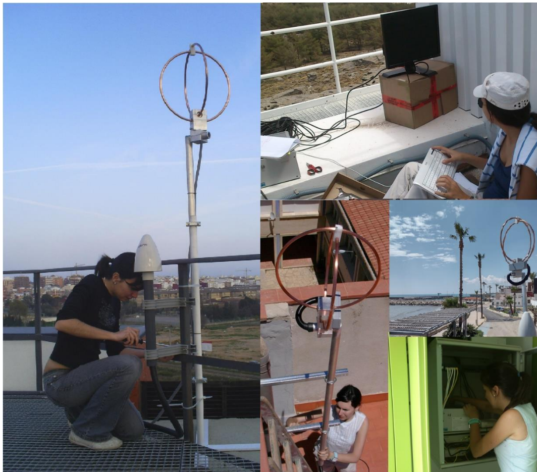
Figura 32. Instalación de sensores LINET.
