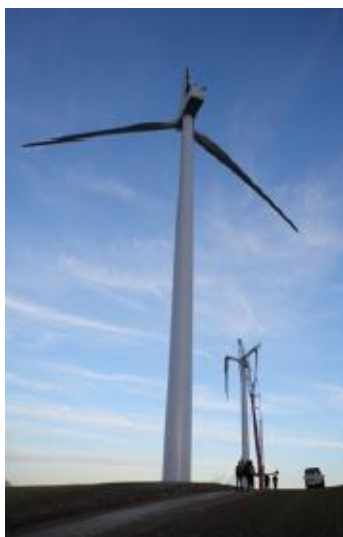
Figura 39. Rotura de palas por rayo en aerogenerador. (Adaptado de Montanyà et al., 2014).
