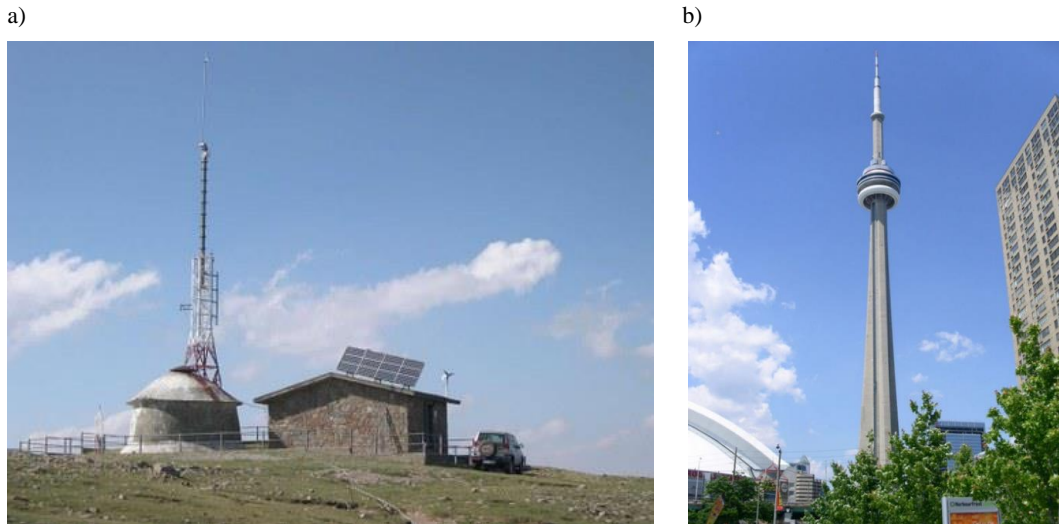
Figura 20. Torres instrumentalizadas para medida de rayos. a) Niu de l'Àliga, Alp (España) (LRG, UPC). b) Torre CN, Toronto (Canada). (© Philip Oldfield)
