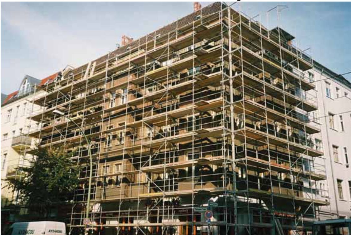
Edificio en rehabilitación en Boxhagenerstraße con Simon-Dach-Straße.
