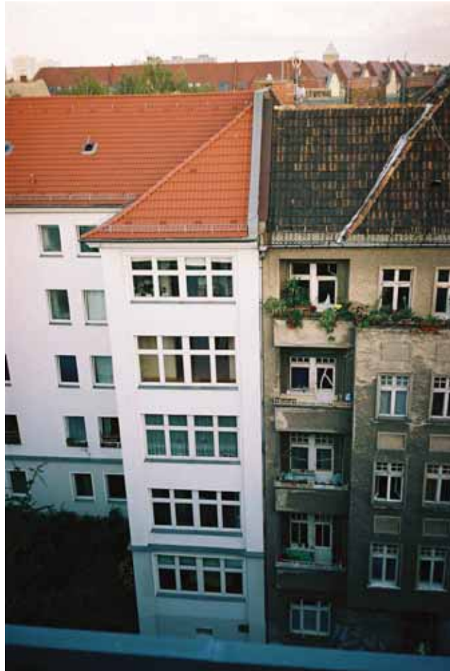
Contraste entre edificios rehabilitados y no rehabilitados en Seumerstraße
