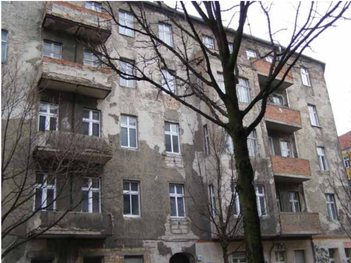
Edificio Altbau no rehabilitado en Jungstraße.
