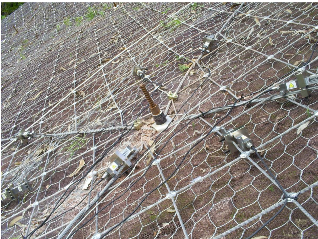
Figura 44.- Tercera zona de medición. Vista en detalle.
