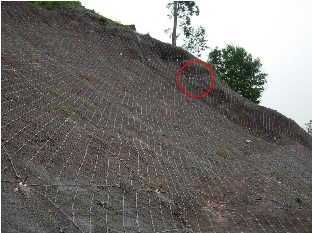
Figura 39.- Primera zona de medición. Vista alejada.
