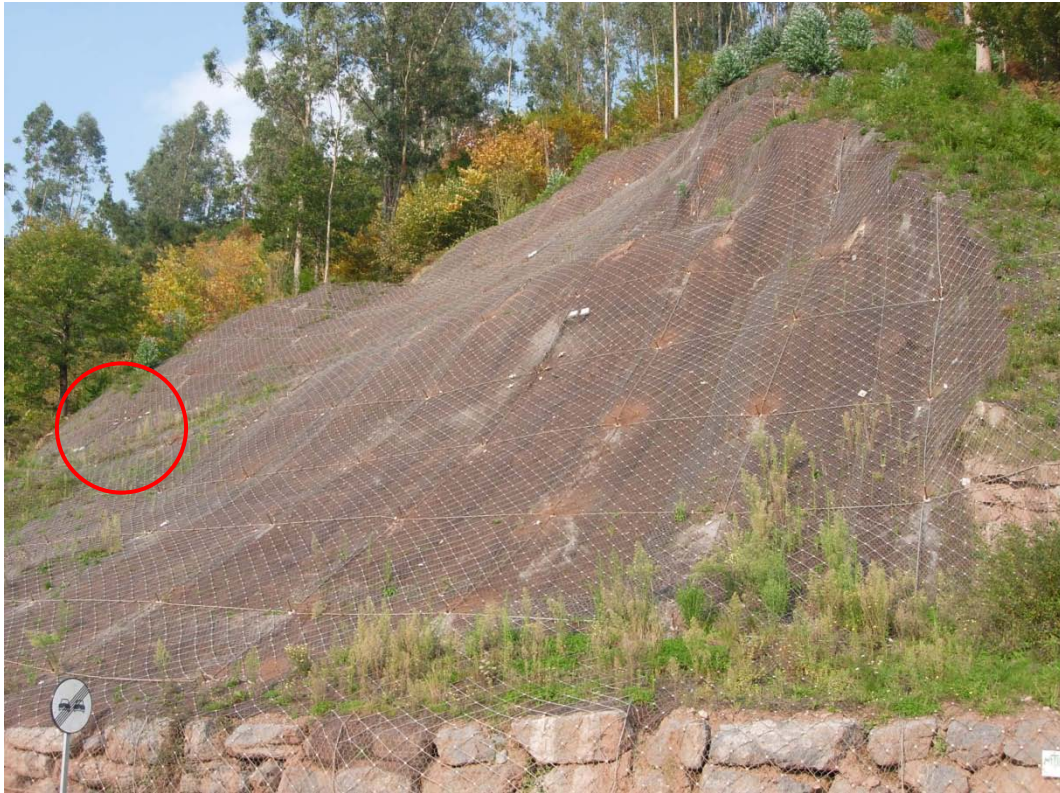
Figura 45.- Cuarta zona de medición. Vista alejada.
