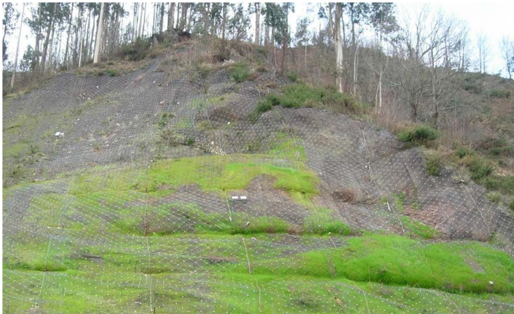
Figura 14.- Sistema flexible reteniendo un deslizamiento.
