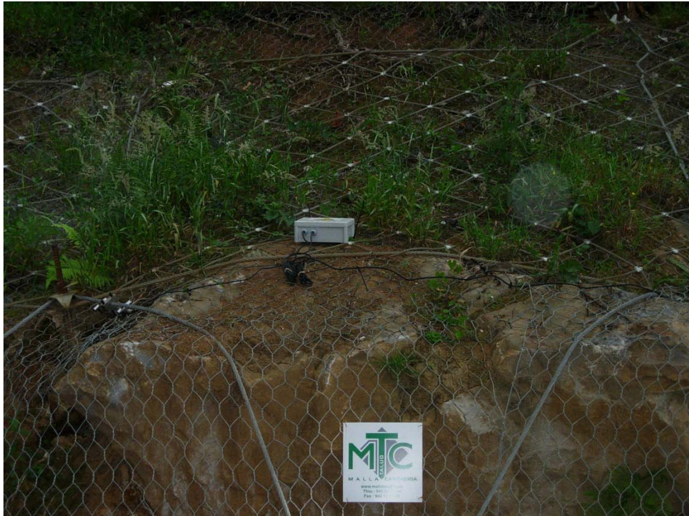
Figura 52.- Geometría inicial de un paño de red típico en Puente El Arrudo.
