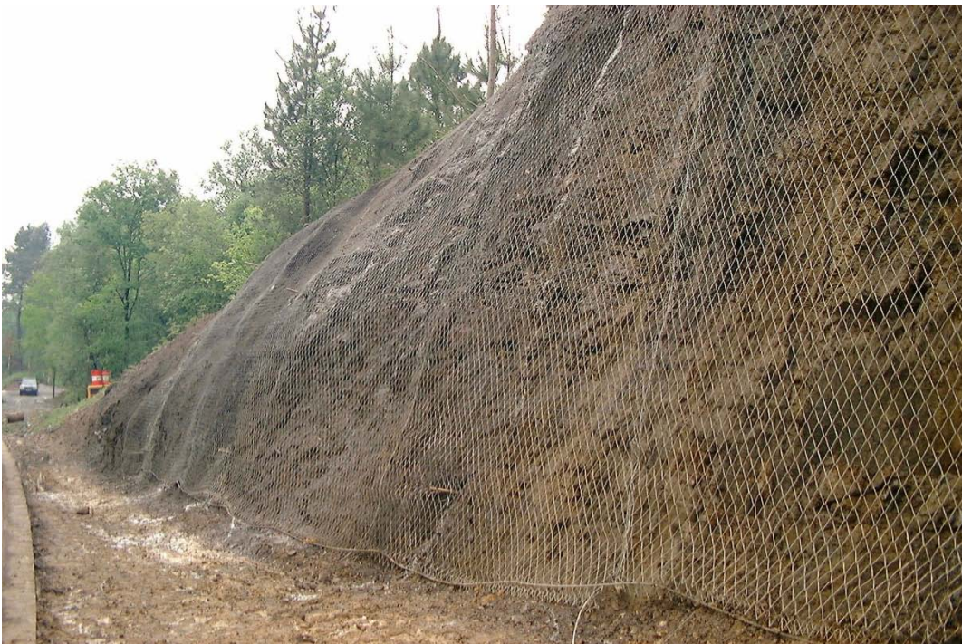
Figura 3.- Membrana flexible anclada al terreno. Ejemplo de malla de alambre de alta resistencia en un talud de suelo (en proceso de instalación).
