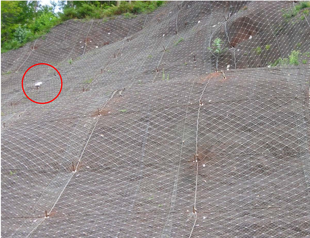
Figura 43.- Tercera zona de medición. Vista alejada.
