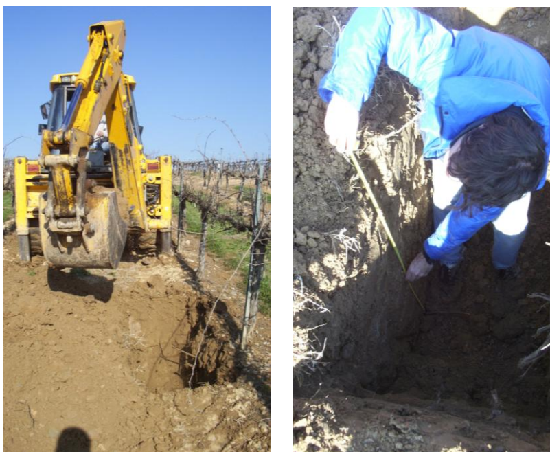
Figura 3.2. Obertura de calicata (izquierda) y medida de la profundidad de suelo explorada por las raíces (derecha)
