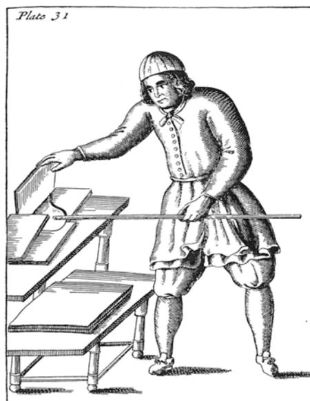
Fig. 78-79 Mojado del papel. Toma de pliegos impresos con el espito o calgador
