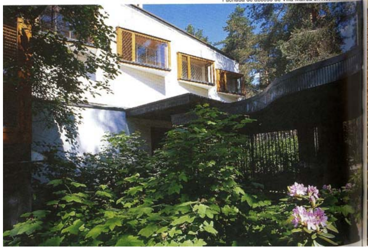
Fig. 32: Fachada acceso a la villa Mareia. Las ventanas en voladizo de los dormitorios son de concepción muy moderna. La carpintería de madera destaca sobre el estuco blanco de la fachada.
