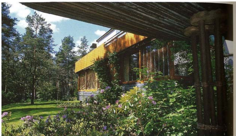
Fig. 31: Acceso a la villa Mareia. La fachada de la zona de estar es muy acristalada y esta forrada de madera, con la intención de recuperar los materiales, texturas y colores del entorno.
