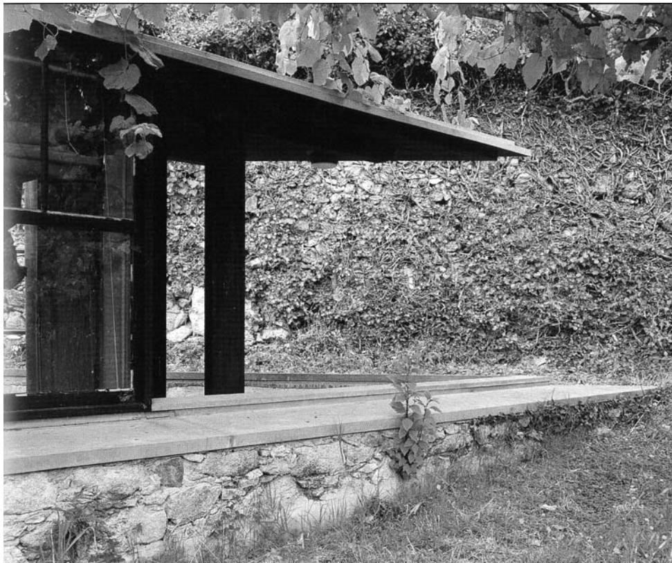
Fig. 38: La ventana en esquina y el gran voladizo de estructura metálica con el murete de piedra que se prolongan hacia el exterior permiten integrarse con el entorno.
