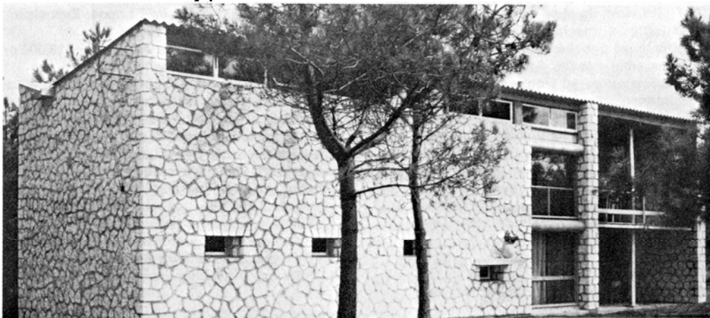
Fig. 21: Aplacado de piedra utilizado en la casa Errázuris. En esta obra utilizó materiales y procedimientos constructivos tradicionales de acuerdo con una nueva sintaxis, en busca de una imagen nueva. “ La rusticidad de los materiales no es de ninguna manera una traba para la manifestación de un plan claro y una estética moderna” 11
