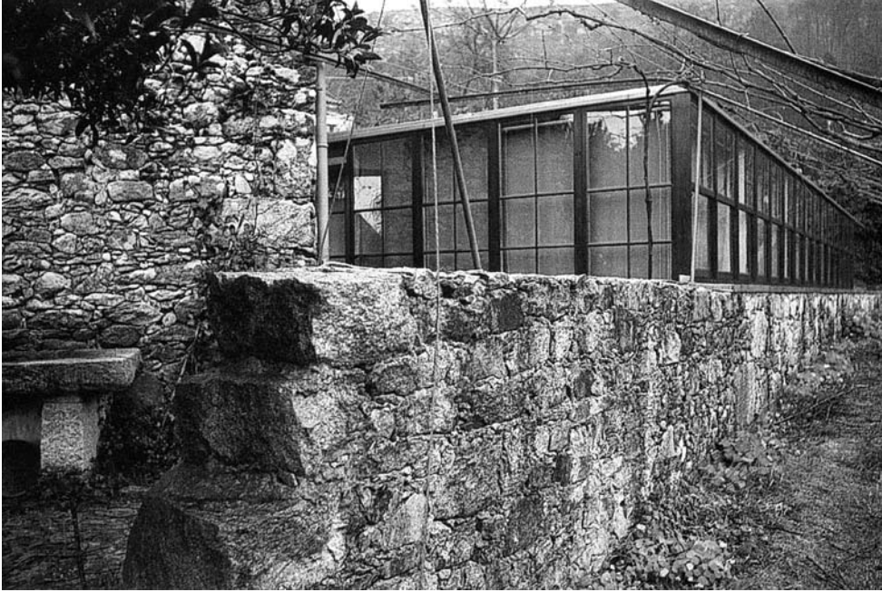
Fig. 37: Vivienda Alcino Cardoso. Un largo zócalo de piedra ancla el edificio al suelo y sirve de base de apoyo para la parte superior de la fachada formada por una estructura ligera y acristalada.
