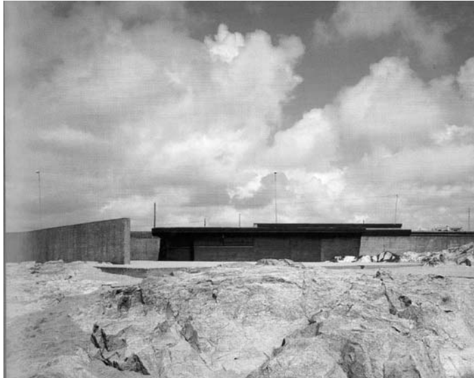
Fig. 35: Piscinas en Leça da Palmeira, 1961-1966. Alvaro Siza. Las rocas, el hormigón y la madera, un juego rico de contrastes.
