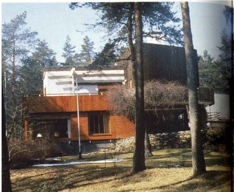
Fig. 33: Fachada lateral con acabado de estuco blanco, madera y piedra.
