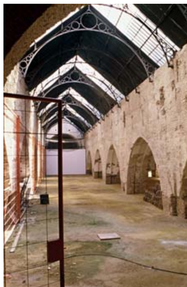
Una nau de la Drassana bètica tal com es troba avui dia. S'observen els arcs apuntats, el gruix del mur-aqüeducte i el nivell actual del terra (Foto de l'autor).
