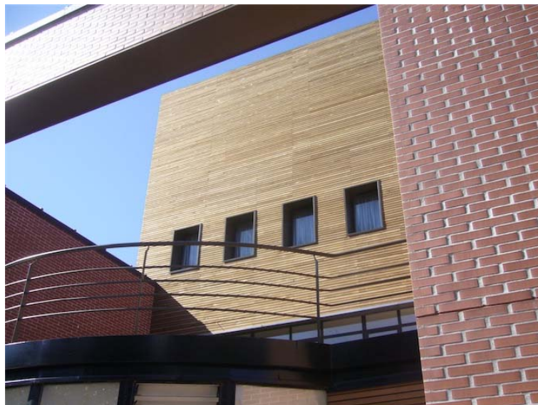
Figura 3.13. Fachada de la E. U. de Magisterio. Arquitectos: Estudio K, Iñaki Arrieta. San Sebastian. 2011. Madera termotratada.
