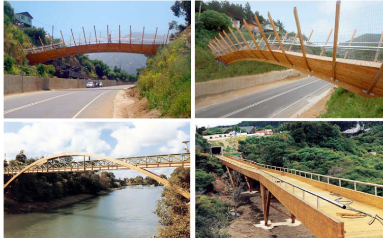
Figura 3.14. Puente de madera laminada de 24m en Chile y puentes de 66 m de luz y puente de 86 m de longitud en Nueva Zelanda.
