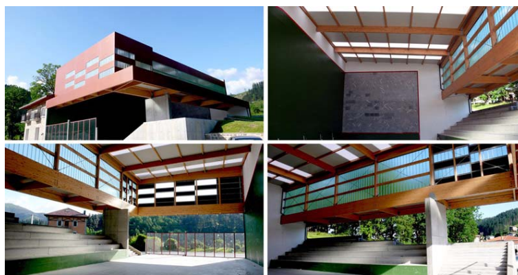
Figura 3.4. Frontón Ermitaberri. Arquitectos: IA+B Arkitektura. Zeberio, Vizcaya. 2007
