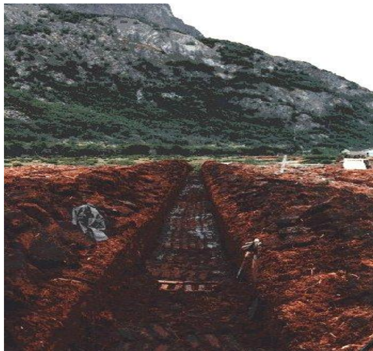
Fotografía N° 2.1. Zanja de extracción cavada a mano en una turbera ubicada en la zona sur de Tierra del Fuego.
